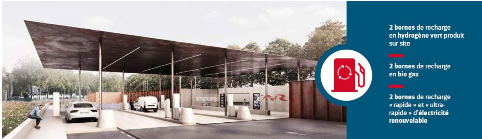
Station de recharge en énergies vertes du Quai des Énergies mise en place par CNR
